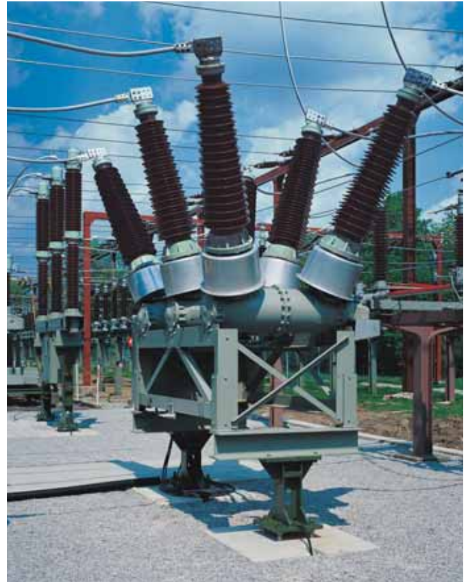
Fig. 4.1-10: 3AP1 dead-tank circuit-breaker 145 kV
