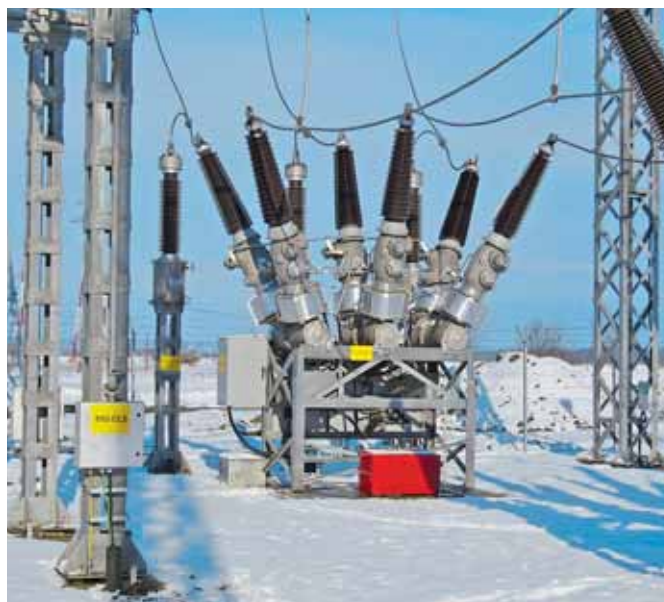
Fig. 4.1-15: 3AP1 DTC 145 kV
